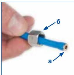
8. На трубку с запрессованной латунной втулкой (а) наденьте накидную гайку (б) из комплекта крана для чистой воды
