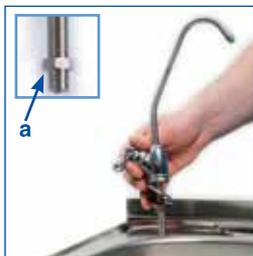
7. Вставьте хвостовик крана в отверстие. Наденьте на него пластиковую шайбу, металлическую шайбу и закрепите крепежной гайкой (а)
