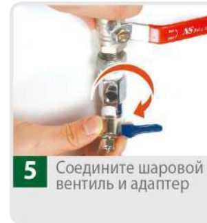
3 Соедините основной шаровой вентиль и адаптер
