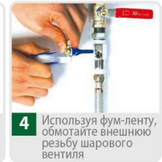
3 Используя фум-ленту, обмотайте внешнюю резьбу основного шарового вентиля
